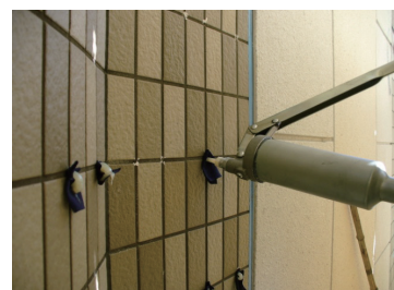
「NEO ONE®」でタイルの浮きを補修する例
